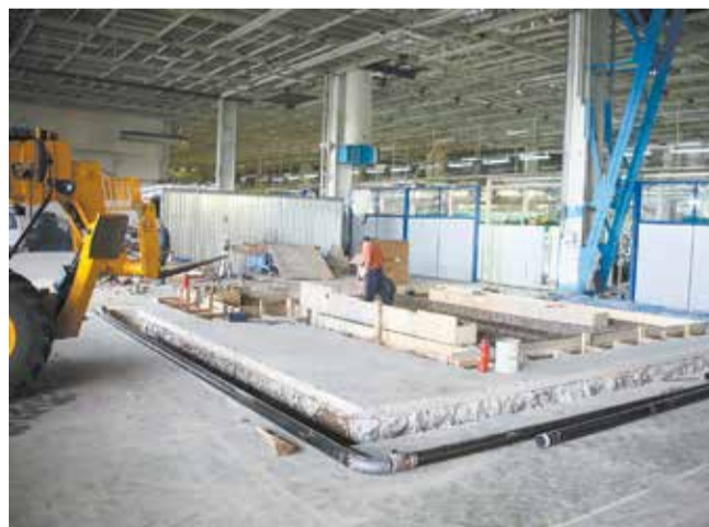
Идёт монтаж фундамента под дождевальную камеру
