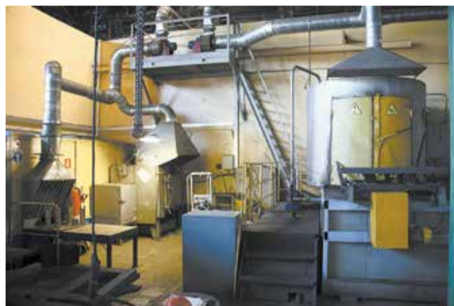
Система вытяжной вентиляции избавила от едкого запаха всех рабочих, занятых разборкой двигателей
