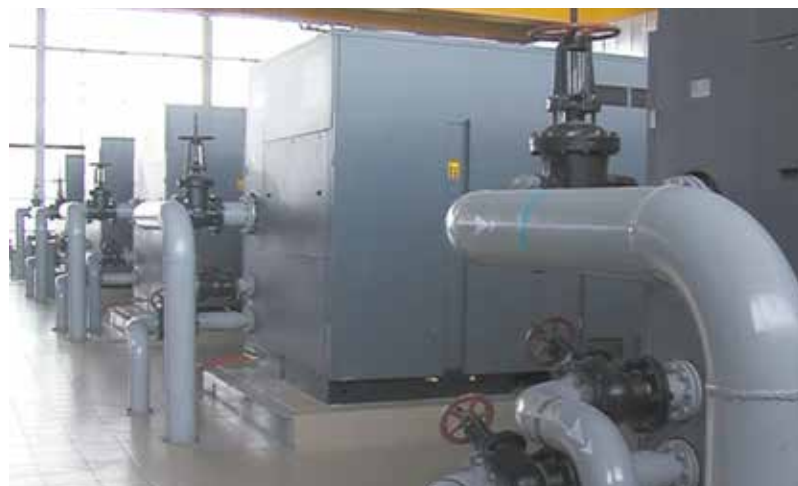
Мероприятия по устранению утечек позволили вывести в резерв один из восьми компрессоров, вырабатывающих сжатый воздух. А в перспективе будет достигнуто четыре-пять
