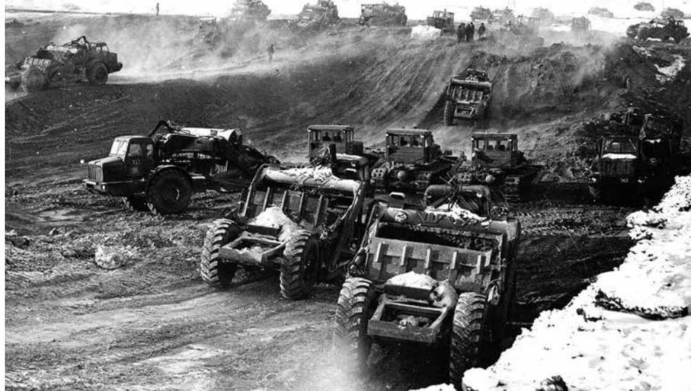
Генплан литейного завода был утверждён 22 мая 1970 года. Он предусматривал строительство четырёх корпусов — серого и ковкого чугуна, стального литья, цветного литья и КВЦ. Под КСКЧ отводилось 18 гектаров земли. Глубина фундамента по проекту доходила до 9,5 метра
