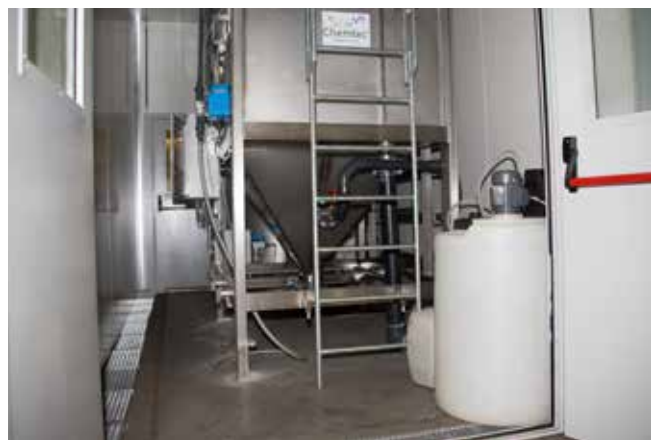
В дешламаторе вода очищается от отходов
