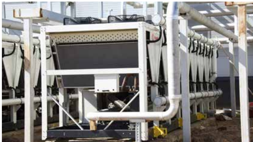
Мощные чиллеры необходимы для охлаждения технологического оборудования и понижения температуры в корпусе
