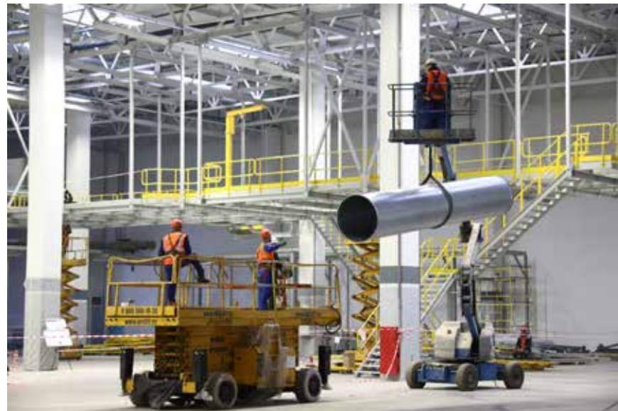
Мощные воздухопроводы вентиляционной системы необходимы для эффективной очистки воздуха рабочей зоны
