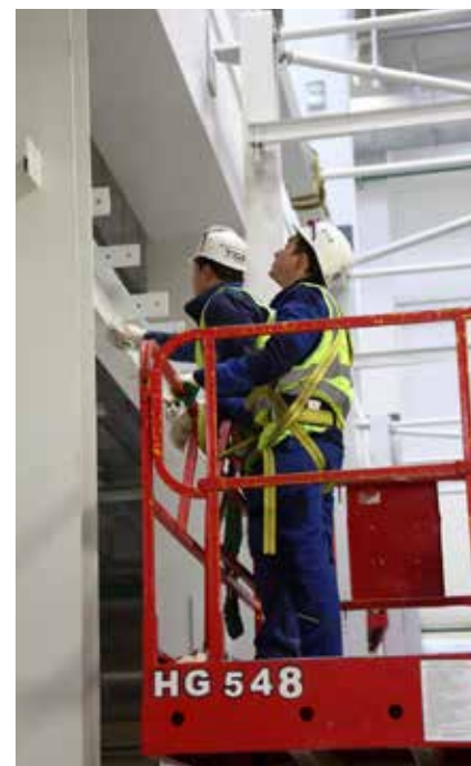
После монтажа каждая балка тщательно моется
