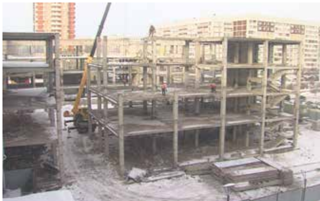
Рабочие снимают 15-30 бетонных плит в день. Сейчас разобрана примерно пятая часть здания
