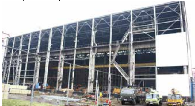
На фасаде корпуса ПРЗ начали устанавливать новые стеновые панели
