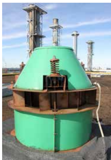
Таких крышных вентиляторов над гальваническим цехом установлено 20
