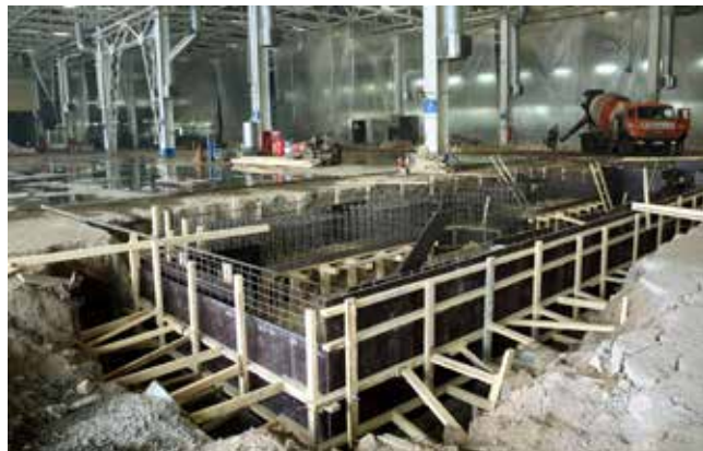
На этом месте расположится линия окраски двигателя. Сюда уже залито 500 кубометров бетона
