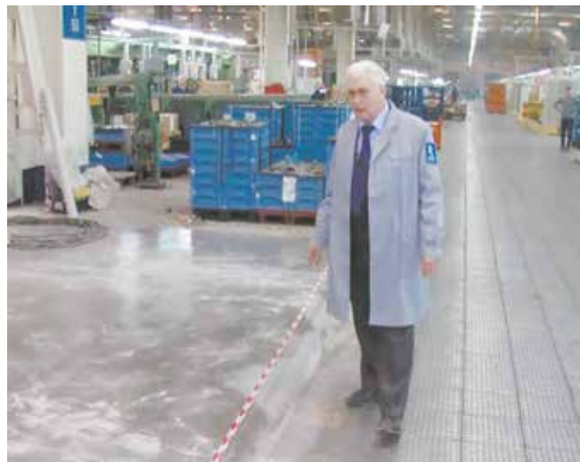
Владимир Баринов показывает новый сверхпрочный пол, способный выдержать нагрузку до пяти тонн на квадратный метр
