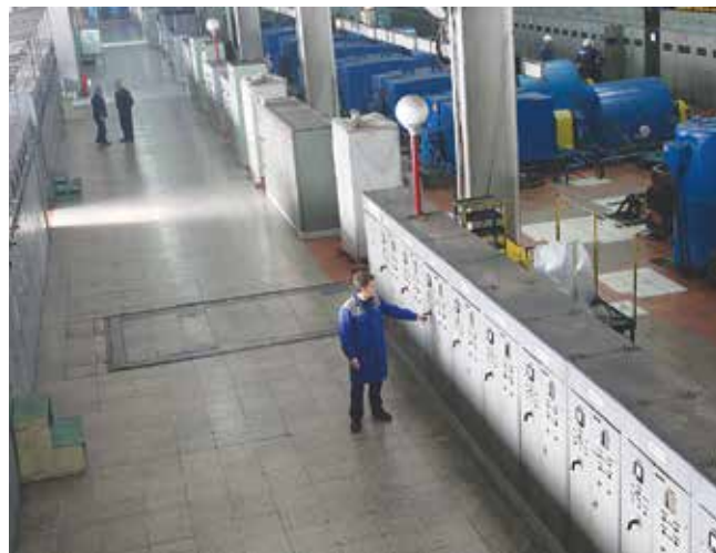
Главная задача машзала — бесперебойная подача токов высокой частоты на нагревательные установки
