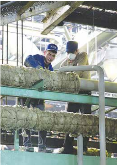
Сейчас рабочие изолируют трубы нового агрегата. Всю тепловую энергию надо сохранить!
