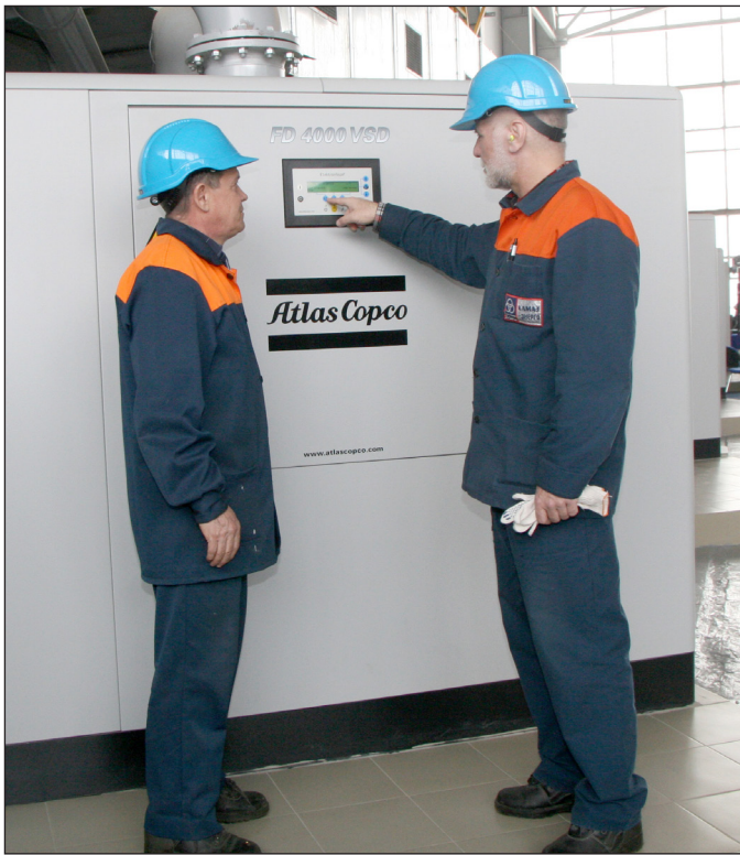
Интеллектуальные центральные системы управления позволяют регулировать производительность в зависимости от потребности производства в сжатом воздухе
