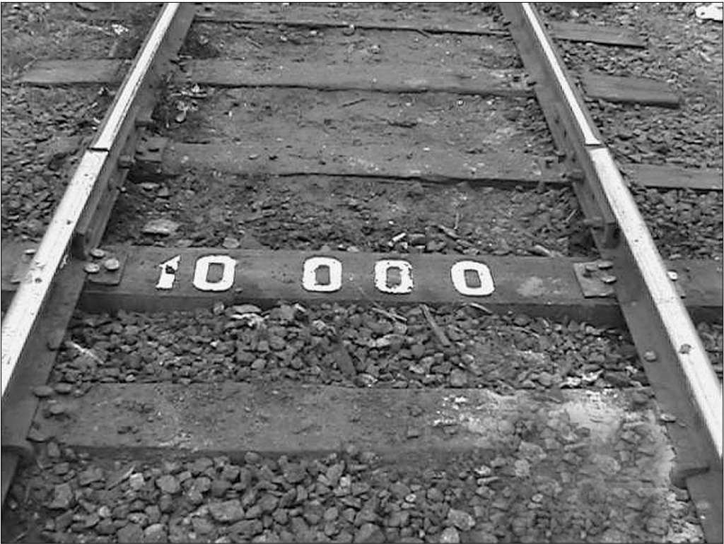
Уложена 10000-я шпала
