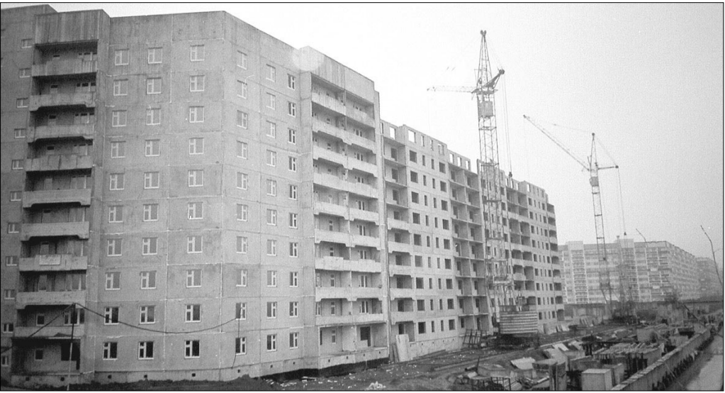
18/10, ударными темпами возводимый на проспекте Вахитова, один из последних домов, «посаженных» на готовые инженерные коммуникации
