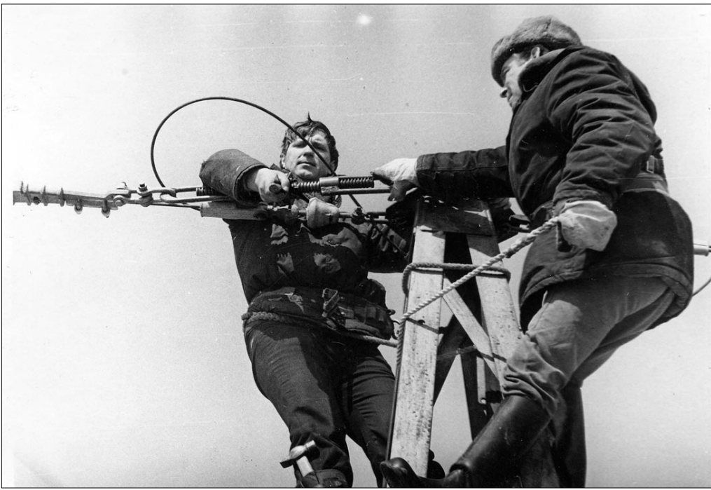
Линия ТЭЦ-РИЗ-1,2 готова к эксплуатации
