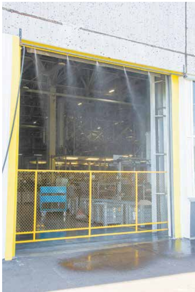
Труба диаметром 50 мм; шланг, по которому подаётся вода, подключён к хозяйственно-питьевому водопроводу; пять форсунок. Конструкция простая, а сколько от неё пользы!
