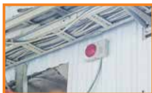
Об открывающихся впереди воротах водителя погрузчика предупредит светозвуковой сигнал
