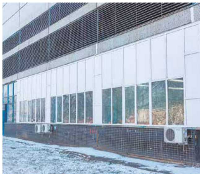
Отслужившие своё окна с металлическими рамами заменили на новые пластиковые
