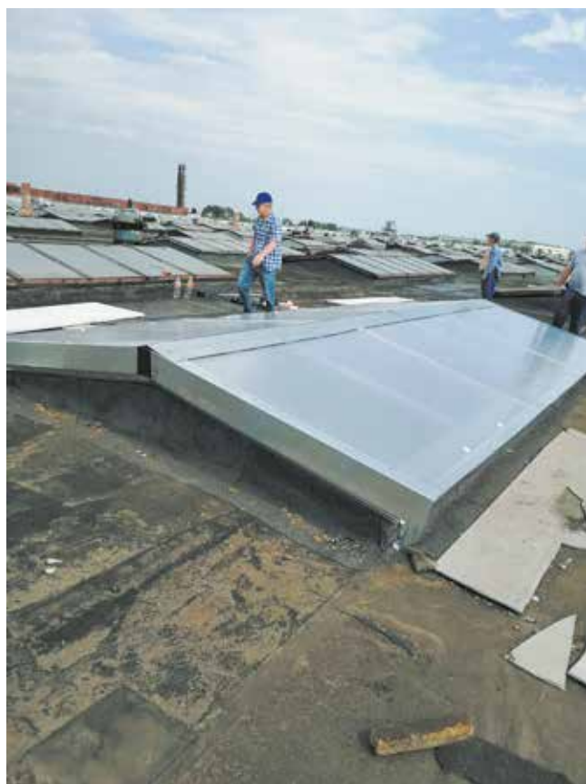
Полсотни зенитных фонарей на крыше заводского корпуса отремонтированы капитально
