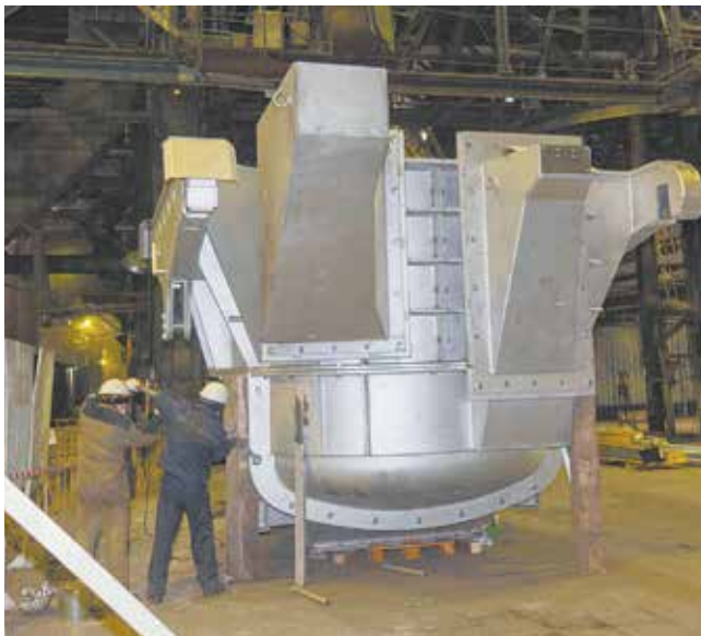
В производстве чугуна идёт монтаж первой из трёх новых индукционных печей выдержки
