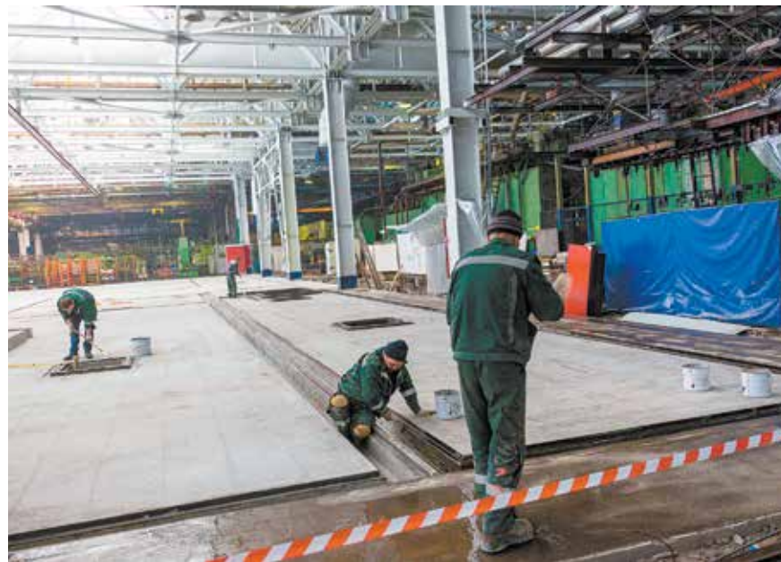
Фундаменты для окрасочной линии должны выдерживать солидную нагрузку
