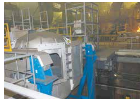
Пока на ПЧЛ идёт монтаж двух индукционных печей выдержки, до третьей очереди дойдёт к концу года
