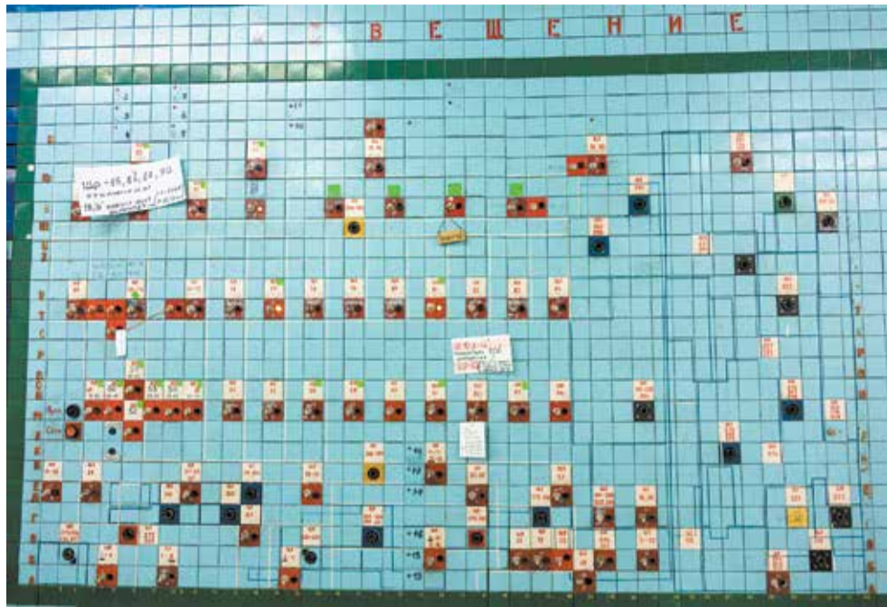
Эта схема управления освещением появилась в диспетчерской ПРЗ в 70-е годы
