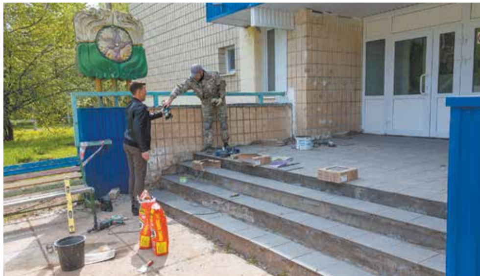
Идёт обновление напольной плитки на крыльце корпуса
