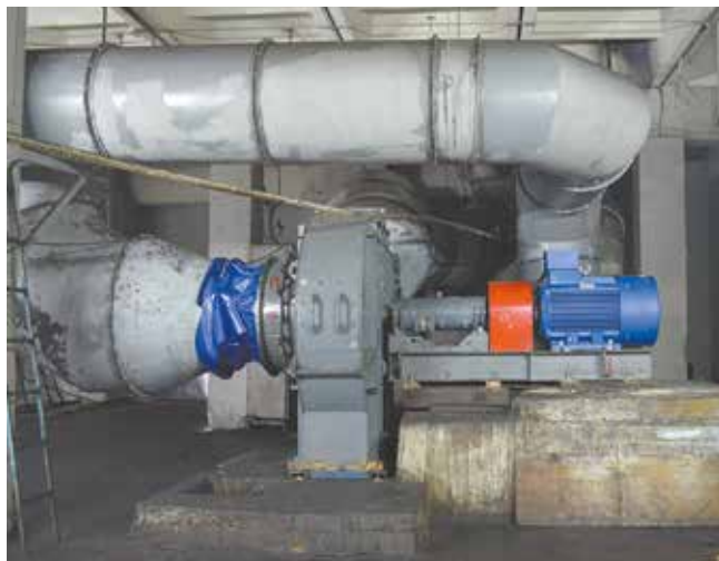
Новый дымосос, установленный в рамках модернизации вентиляционной системы в КПК-1, значительно лучше удаляет дым и пыль из рабочей зоны кузнецов-штамповщиков
