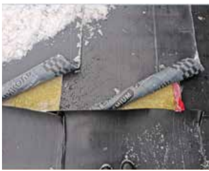
Рубероид подрядчик уложил поверх мокрого утеплителя
