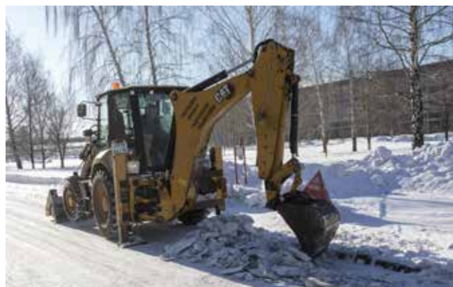
Сначала ковш экскаватора разрыхляет ливнёвку...
