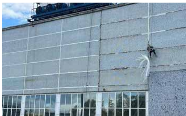
На заводе двигателей заканчивается ремонт межпанельных швов
