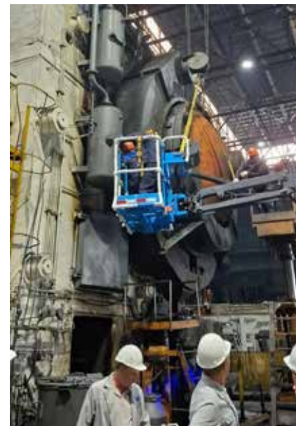
Кузнечный завод. Замена дисковых муфт и тормозов клинового пресса
